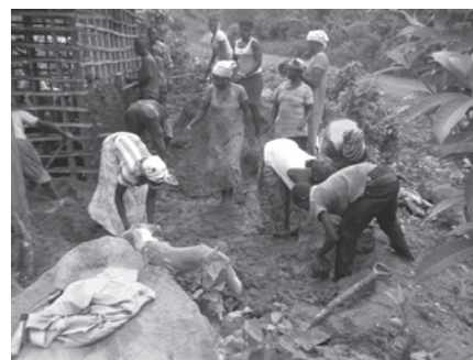
教員住宅建設の様子
